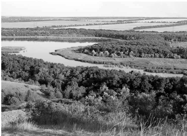
Рисунок 1 – Клебан-Быкское водохранилище. Общий вид
